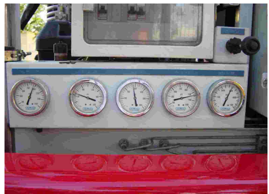
Panel de manómetros
