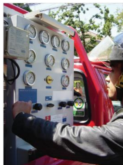
Operador manipulando panel
